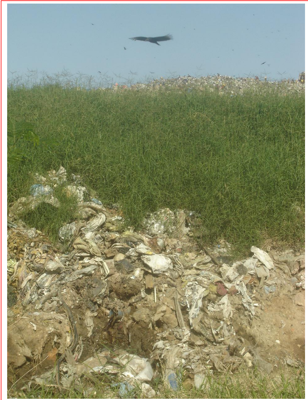
PONTO DE AFLORAMENTO DO CHORUME NO ATERRO MUNICIPAL DE GRAMACHO, RJ
