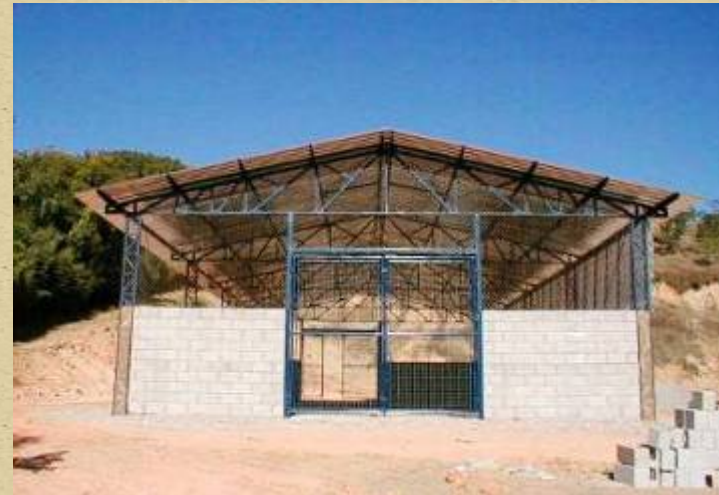
Exemplo de galpão com estrutura metálica
