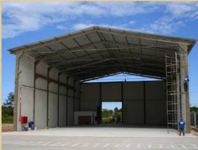
Exemplo de galpão com estrutura de concreto pré-moldado
