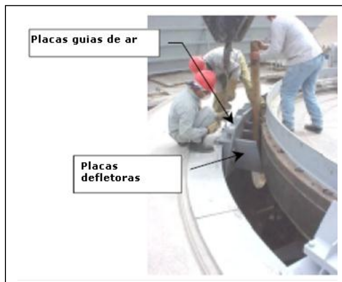
Figura 6.20 - Instalação de chapas (Lafarge, 2007)
