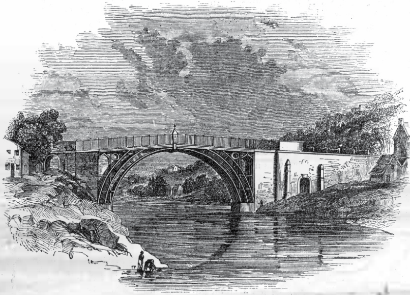
Ironbridge, completada em 1779, em Coalbrookdale, Inglaterra, foi a primeira ponte de ferro fundido a ser construída
